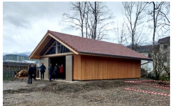
Le nouveau chalet, juste terminé .
